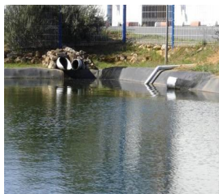
Réserve incendie alimentée par recueil d'eau de pluie
